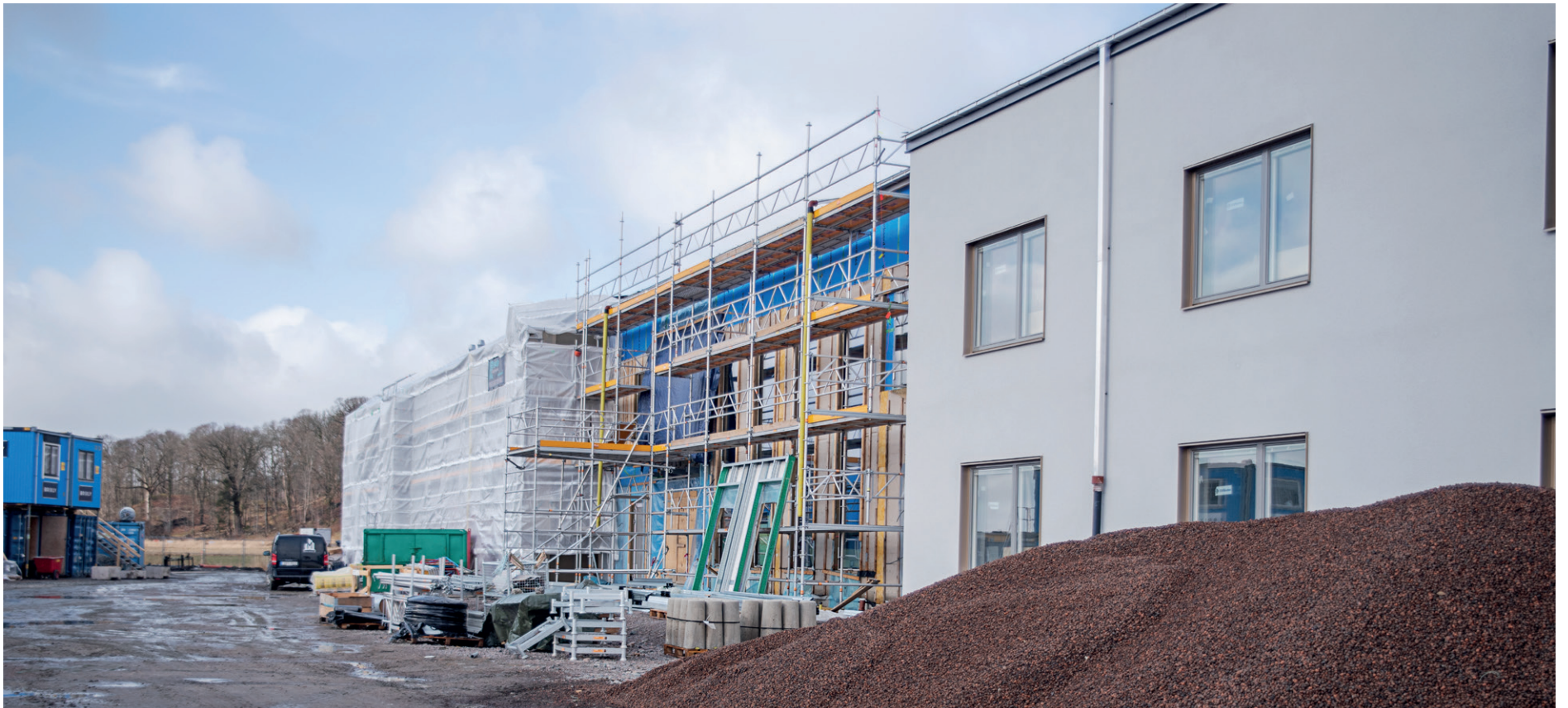
Björkris vård- och omsorgsboende under uppbyggnad.
