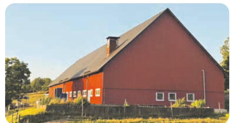
Bertilsgårdens stall har fått ett ansiktslyft med bland annat ny panel, uppdaterad spolspila och renoverad takkonstruktion.
