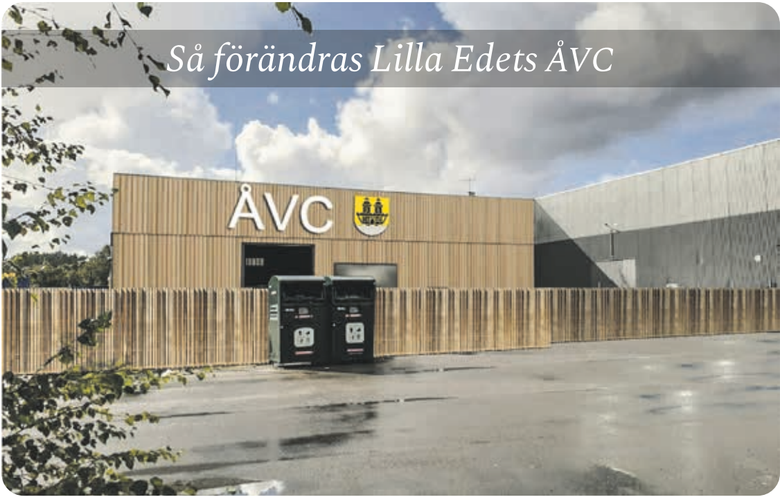
I slutet av året beräknas ombyggnationen av Återvinningscentralen i Göta vara klar. Målet är att förbättra tillgänglighet, service, säkerhet, funktionalitet och arbetsmiljö.
