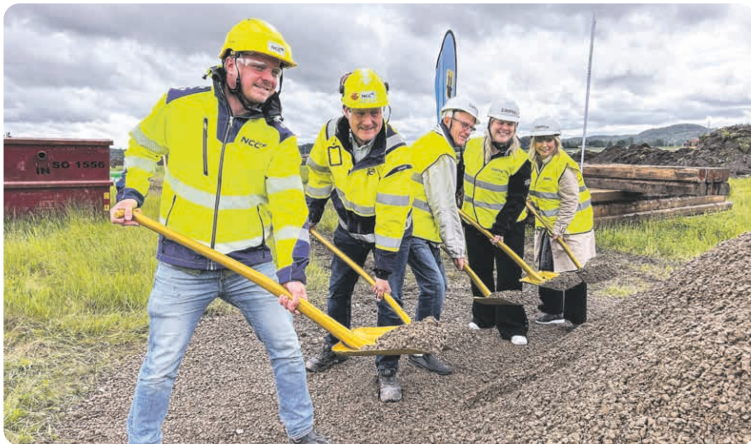
I början av sommaren togs det första spadtaget till Ekebergsskolan. Nu är arbetet i full gång och mycket har hänt på bygget under sommaren.
