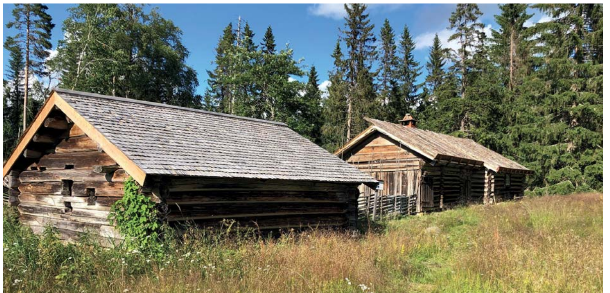
Kommunens byggnader i Skräddar-Djurberga fäbod har fått nytt tak.
