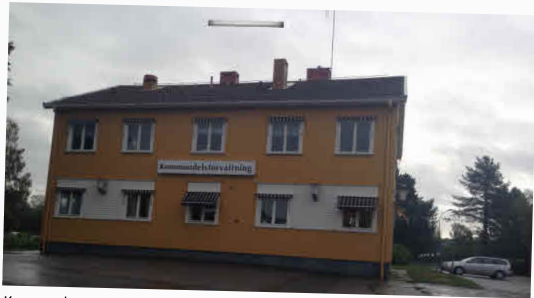
Kommunhuset i Sävar
