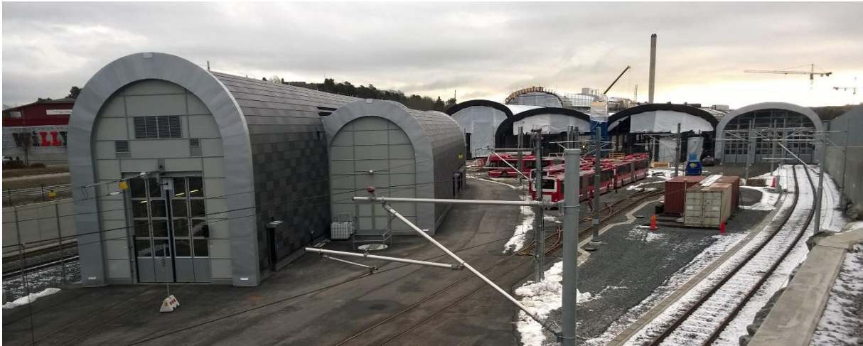
Figur 6 Spårvagnshallarna i Åga snart färdigbyggda för 900 miljoner med plats för Spårväg Citys vagnar
