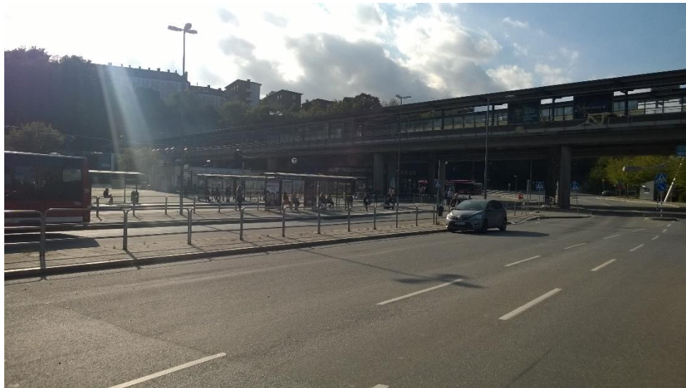
Figur 1 Dagens Ropsten med betong som huvudsakligt intryck
